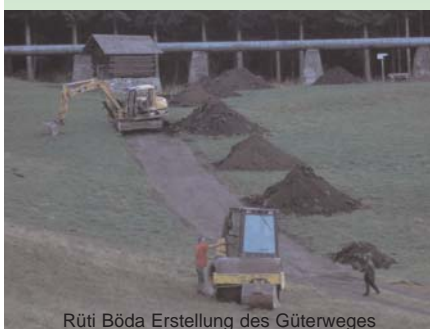
Rüti Böda Erstellung des Güterweges
