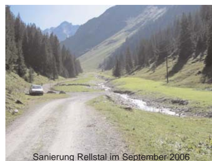
Sanierung Rellstal im September 2006
