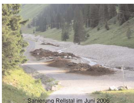
Sanierung Rellstal im Juni 2006
