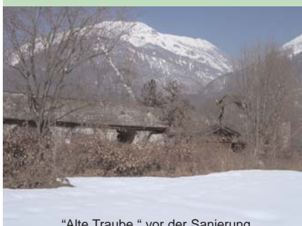
„Alte Traube“ vor der Sanierung
