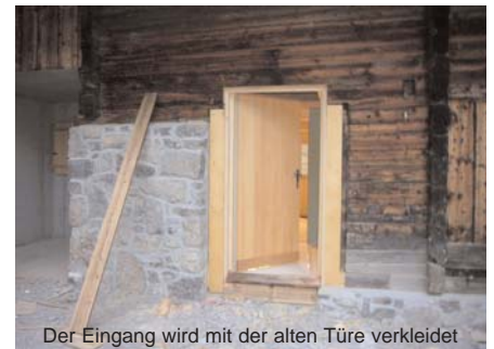
Der Eingang wird mit der alten Türe verkleidet
