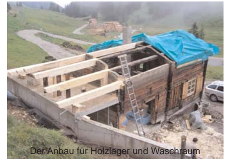
Der Anbau für Holzlager und Waschraum
